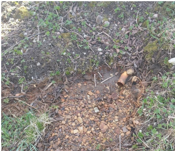
Foto 1. Uhtevee juhtimine veetöötlusjaama seinast toruga välja
