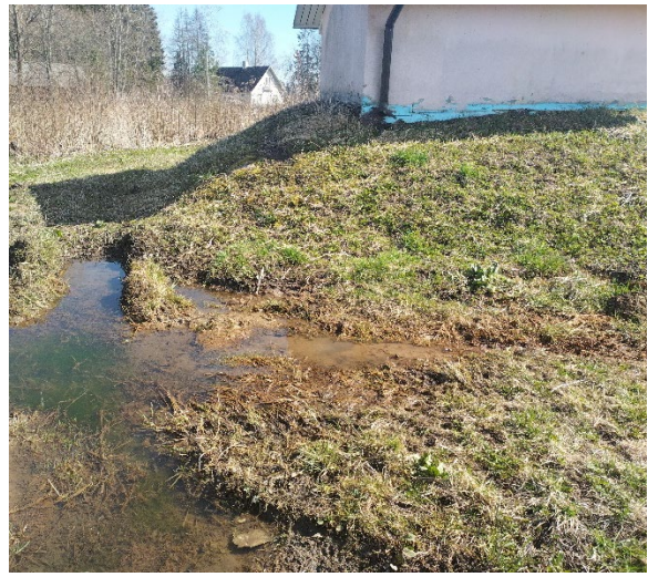
Foto 2. Ummistunud uhtevee immutusväljak puurkaev-pumpla taga
